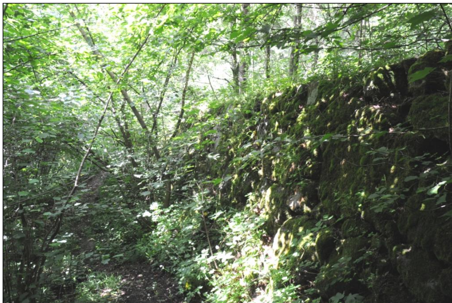
Figura 8 - Argine artificiale nella zona apicale del conoide, in sponda idrografica sinistra
