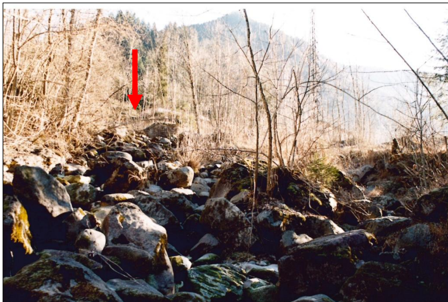
Figura 10 - Alveo del Torrente Sedornia all'altezza di Via Casa Alta appena sotto la briglia (freccia rossa) prima degli interventi realizzati
